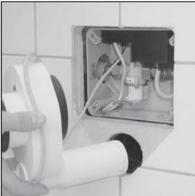
Keramik abnehmen. Sensorsifon herausziehen und Stecker beim Elektronikmodul lösen.
