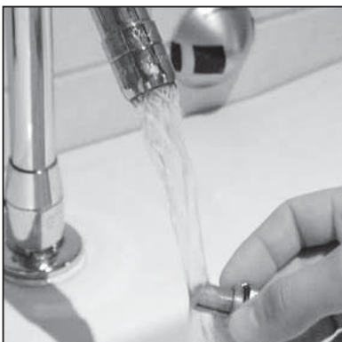
Filter ausspülen, gegebenenfalls austauschen
