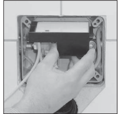
Elektronikmodul aus dem UPKasten entnehmen
