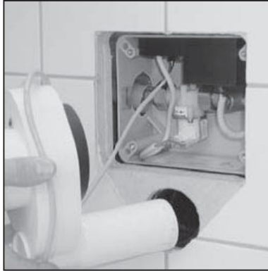
Sensorsifon herausziehen und von der Elektronik abstecken
