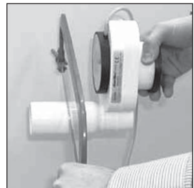
Länge des Sensorsifons an den Ablauf anpassen
