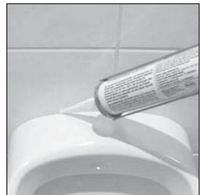
Wasserdichte Silikonverfugung rund um die Urinalkeramik herstellen
