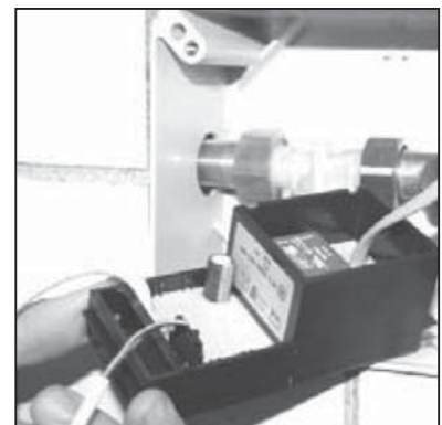
Sensorsifon am Elektronimodul anstecken
