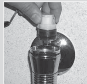
Das letzte Stück des Magnetventil mit der Hand herausschrauben und entnehmen.
